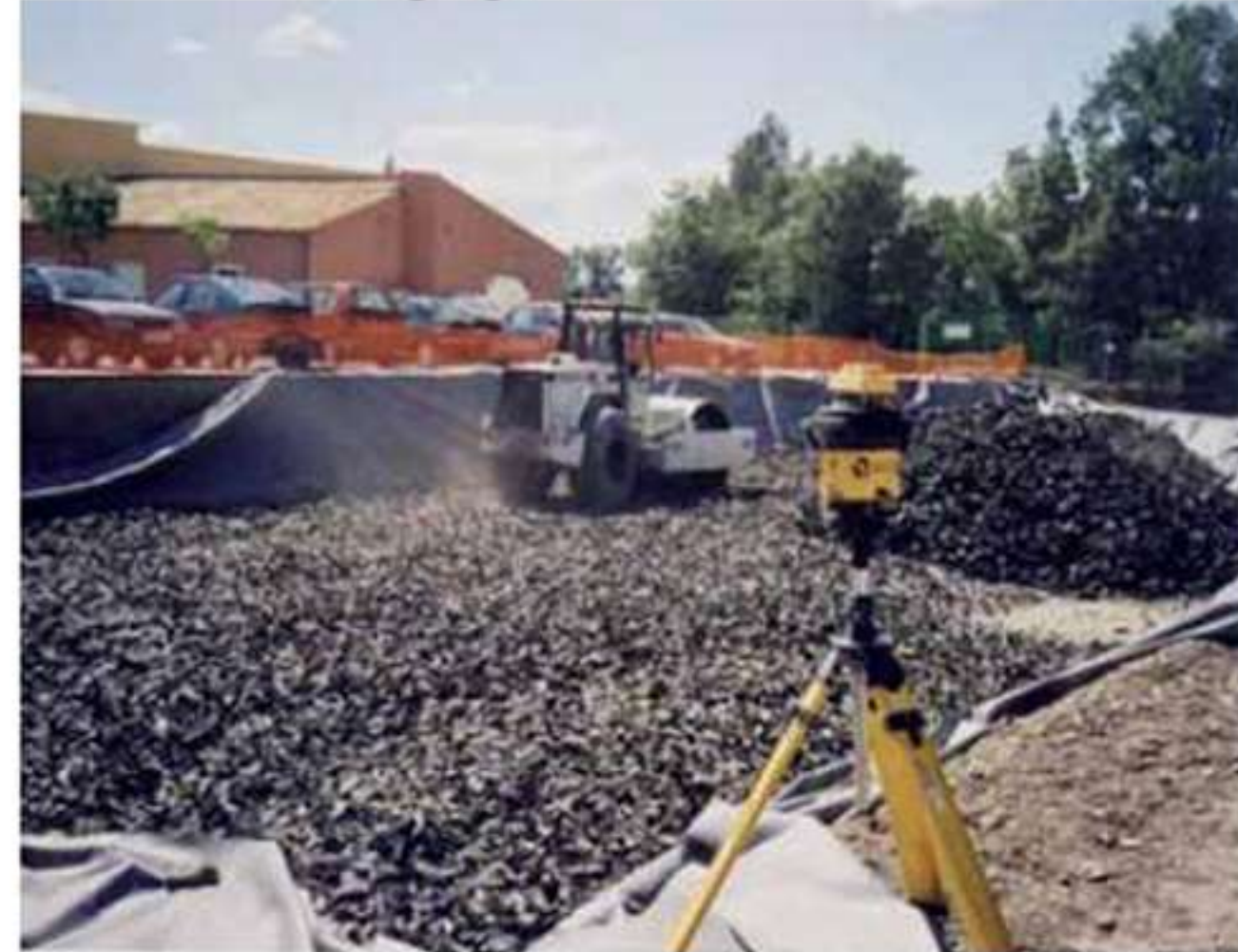
Compactage au rouleau vibrant
