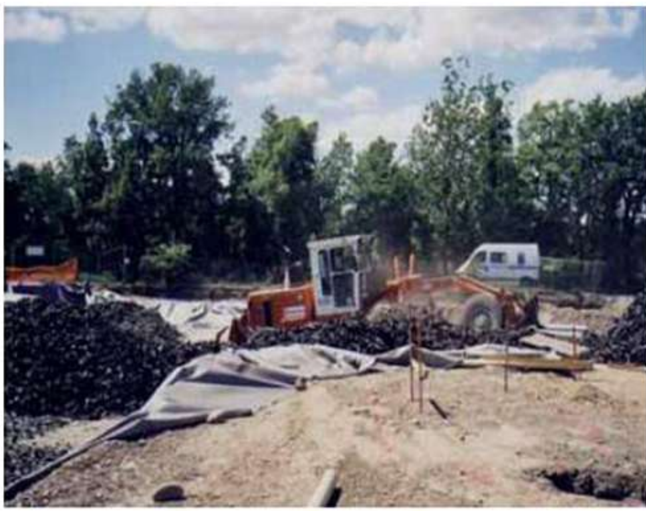
Réglage à la niveleuse
