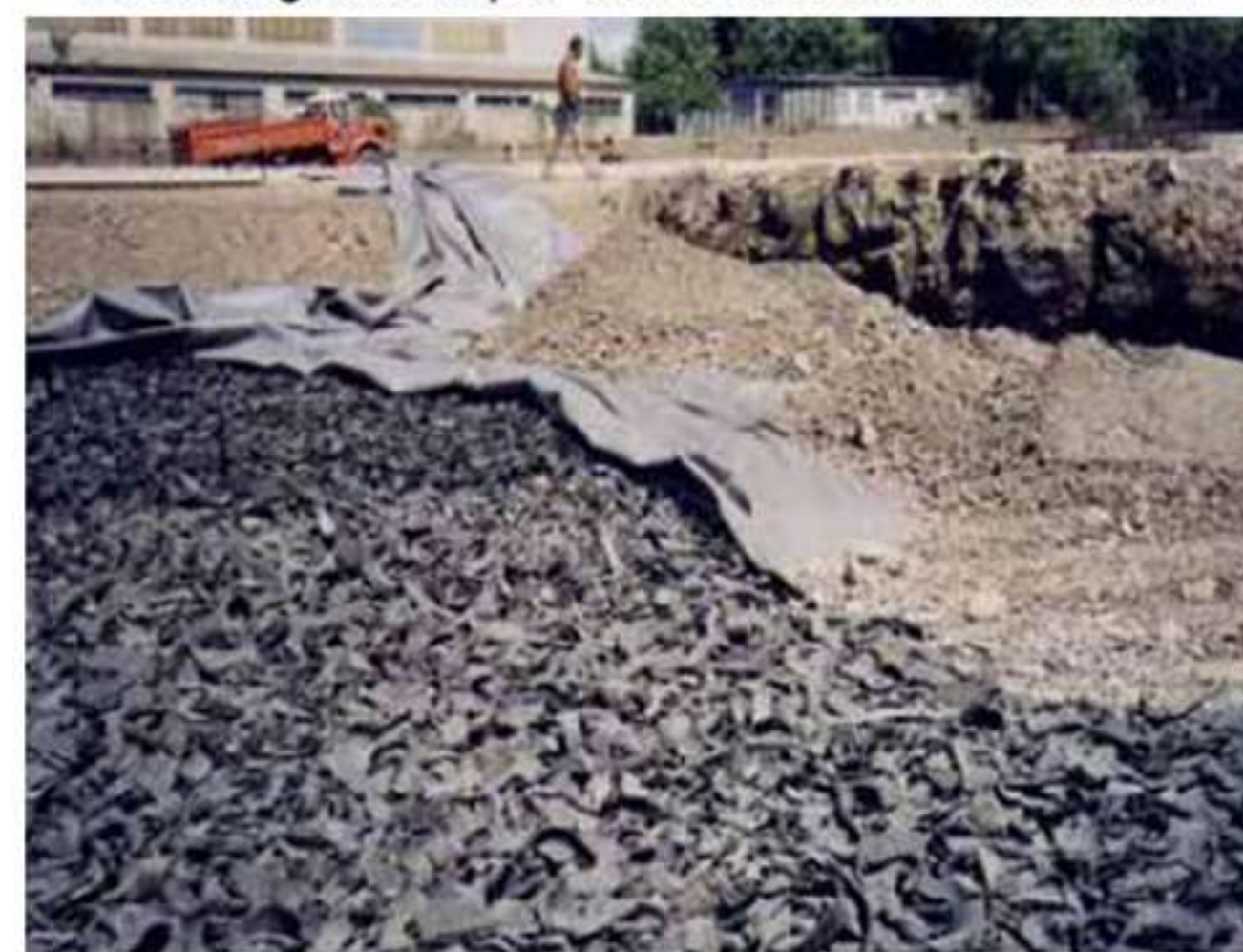
Fin du remplissage et recouvrement par le géotextile avant remblaiement sur 1,5 m
